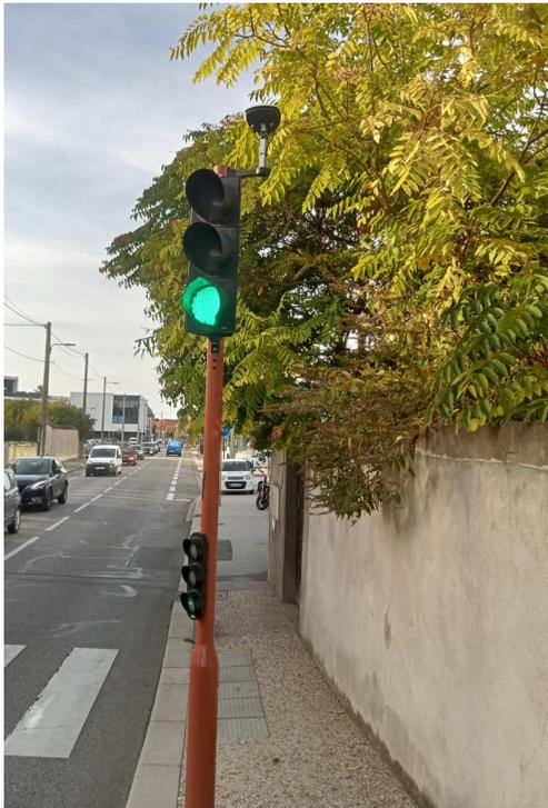
Mise en place de capteurs optiques intelligents sur le carrefour à feux de manière à optimiser les détections de véhicules.
