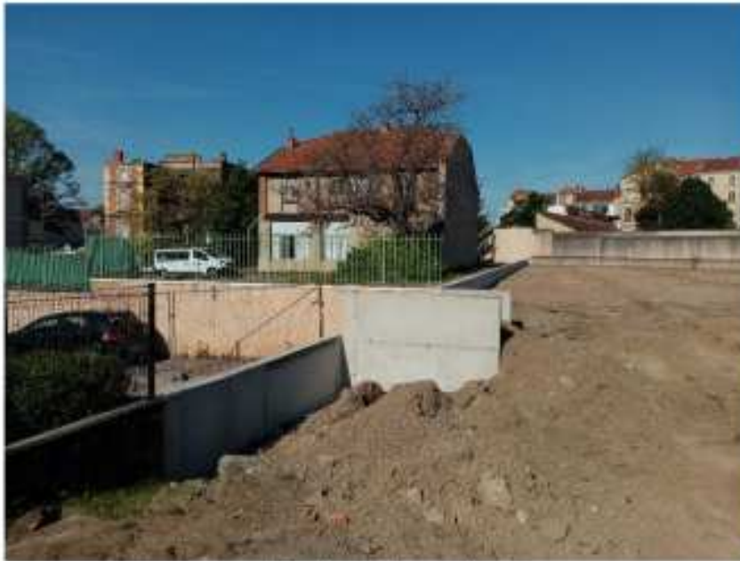
Mur de soutènement
