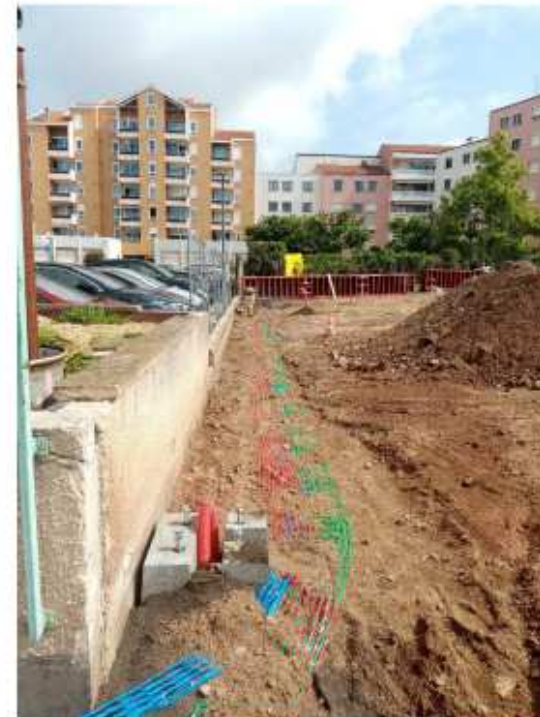
Mise en œuvre des réseaux
