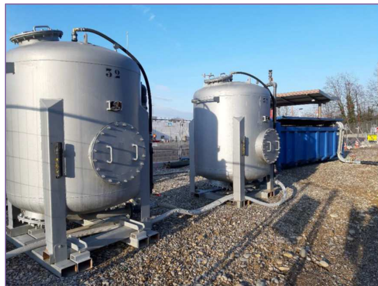
Epuisement et traitement des eaux de nappe avant rejet au réseau
