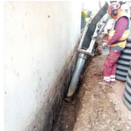
Dégagement pignon immeuble « Grand Angle » sur 2.00m de profondeur
